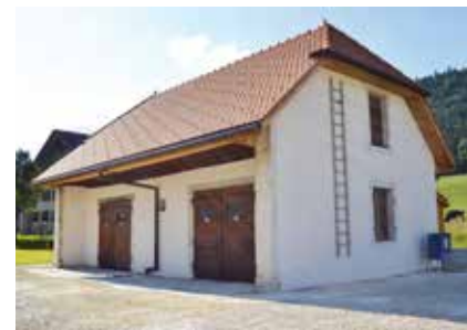
Les travaux de rénovation de la lessiverie de Chézard-Saint-Martin sont à bout touchant. (cwi)
