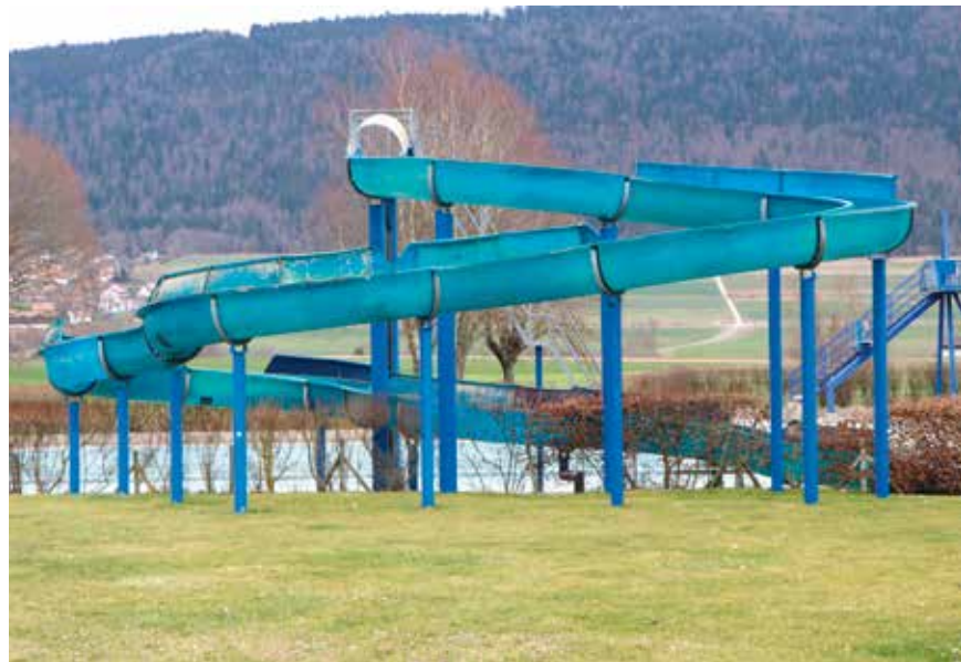
Le toboggan des piscines est au bout de sa vie. Il sera remplacé l'année prochaine. (Photo pif).
